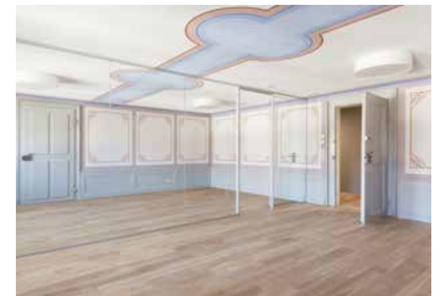
In den Räumlichkeiten mit den wieder zum Leben erweckten Malereien ist die Spitex Zug eingemietet.
